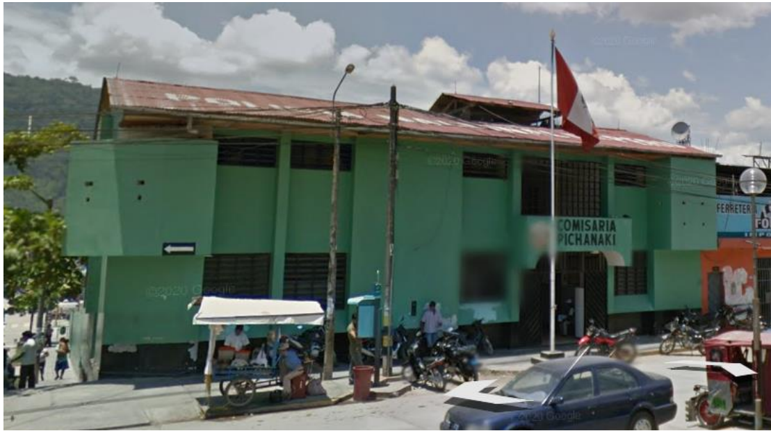
Comisaría de Pichanaqui, Ubicado en el distrito de Pichanaqui, Provincia de Chanchamayo – Departamento de Junin
