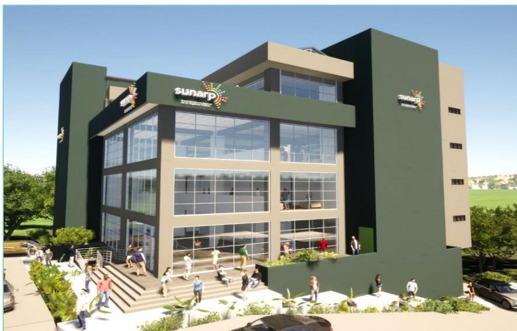
Imagen de la Fachada principal de la Oficina Registral Chimbote
