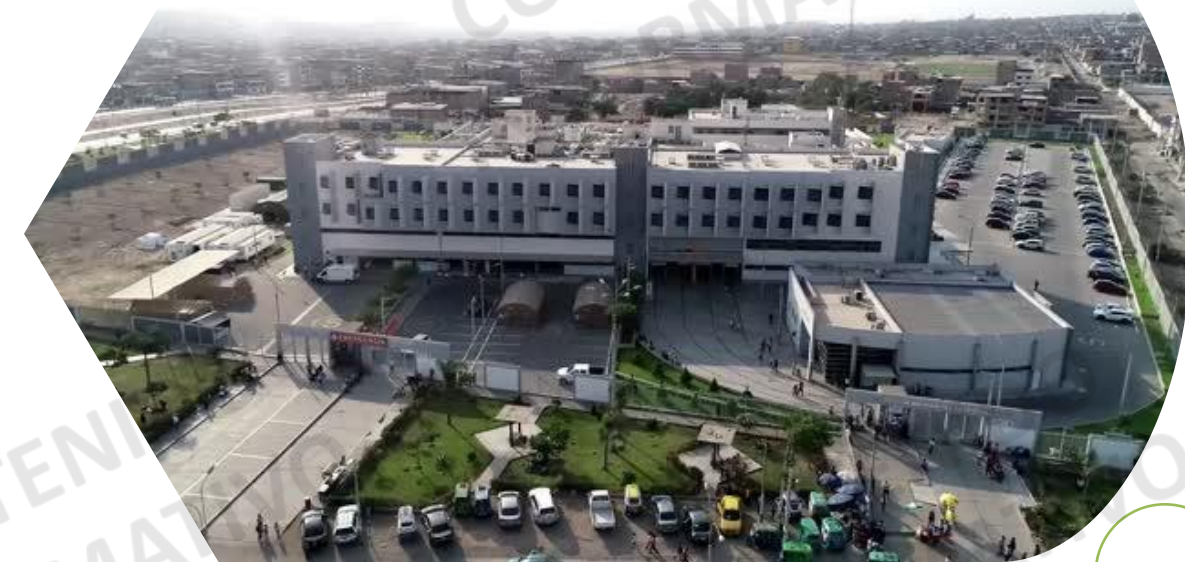
HOSPITAL DE EMERGENCIAS VILLA EL SALVADOR
