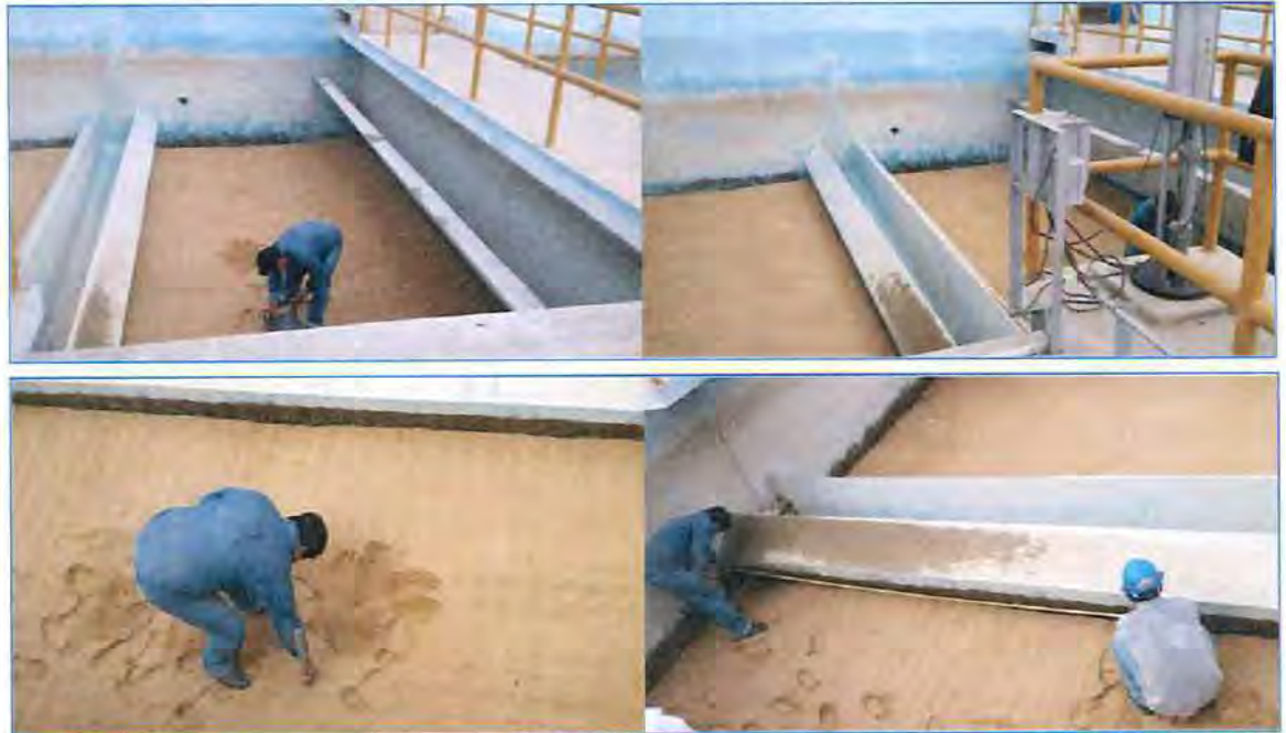
Fig. 32 Extracción de arena Filtros (A-F)
