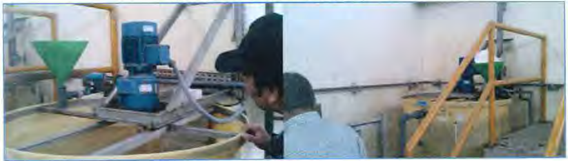
Fig. 35 Electrodosificadores (1 y2)
