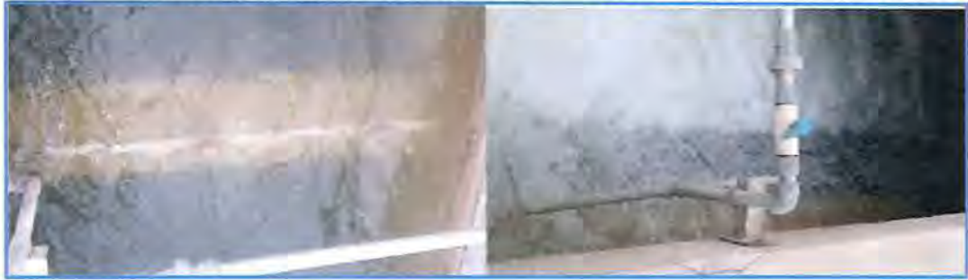
Fig. 14 Punto de aplicación de Sulfato de Aluminio Granular y Polímero Catiónico
