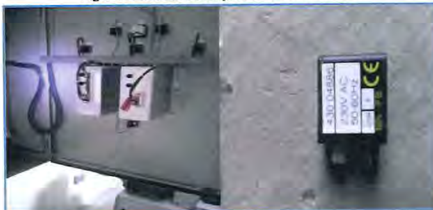
Fig. 22 Cronocontacto y bobina de selenoide
