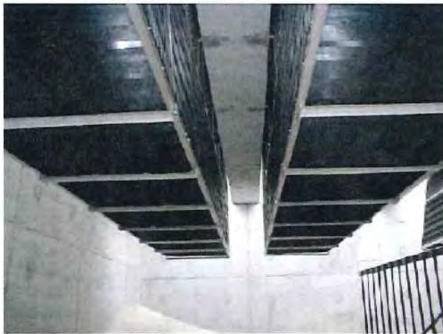
Modulos lamelares (Instalación)
