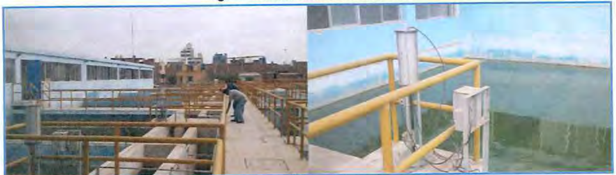
Fig. 27 Cilindros hidroneumáticos
